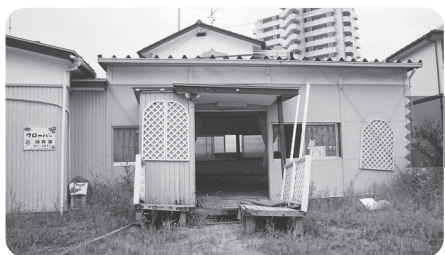
多賀城市 被災幼稚園
